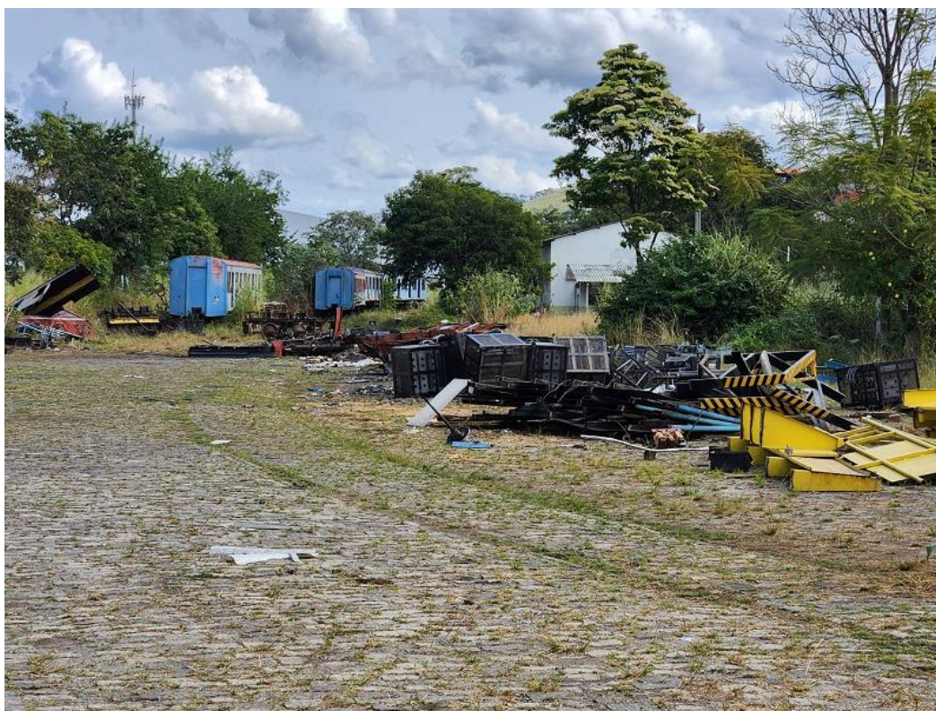
Imagem 8: Pátio com vagões e estruturas de ferro abandonados
