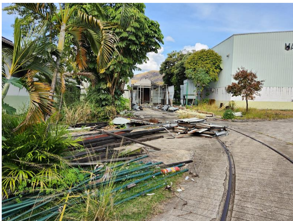
Imagem 6: Galpão secundário em estado de abandono
