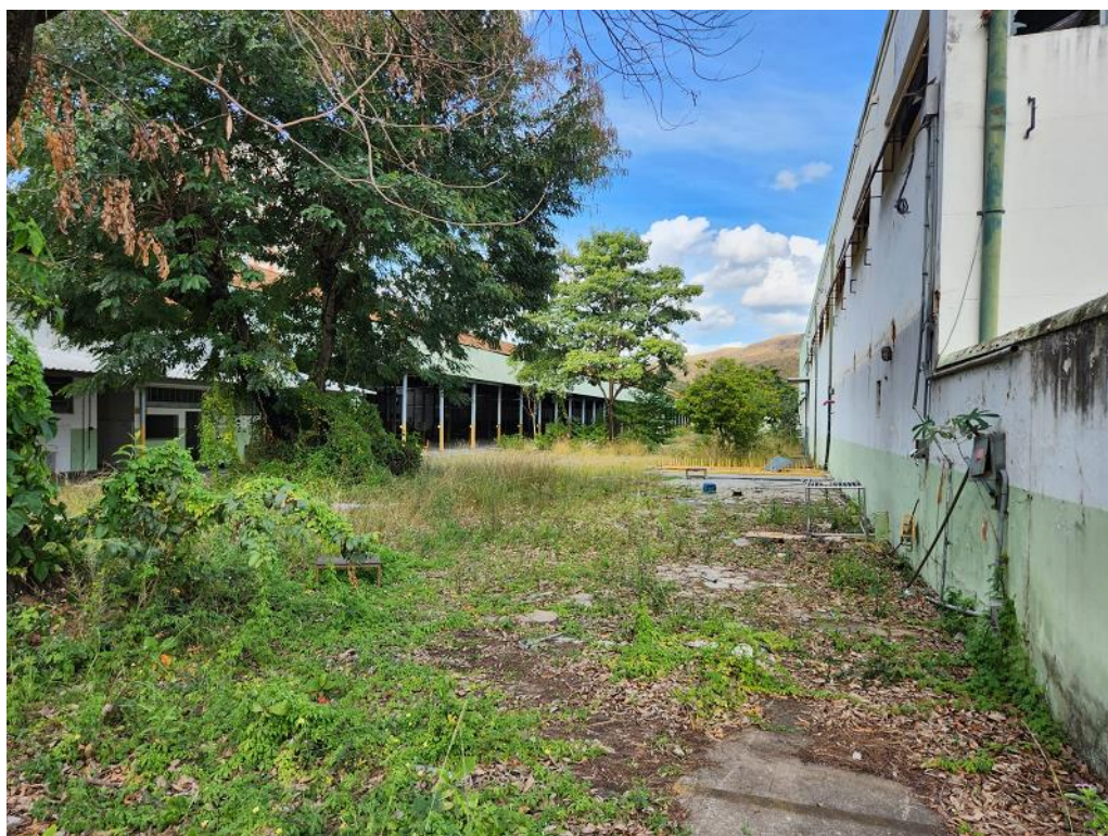
Imagem 5: Galpão secundário em estado de abandono
