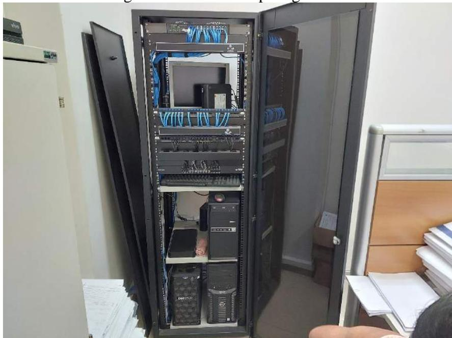
**Foto 31** – Armário grande Alto RACK para guardar servidor E Switch
